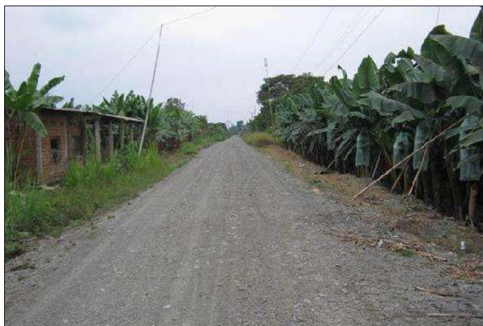
Foto: 3 Camino lastrado de dos vías
