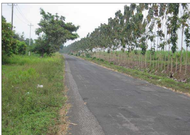
Foto: 4 Camino pavimentado de dos vías
